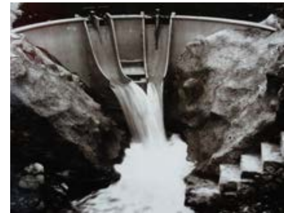
ci-dessous : maquette du barrage, ©EDF
