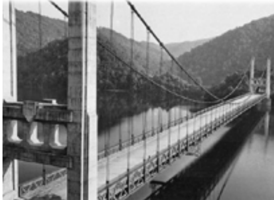
Le nouveau pont de Saint-Projet
